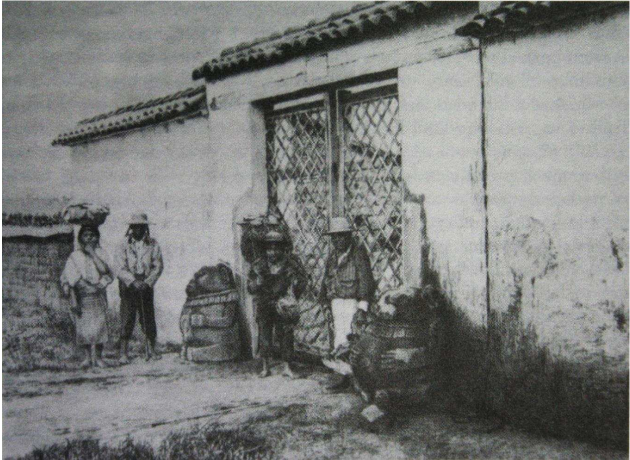
Figura 135. Entrada a la Quinta Arévalo. Fotografía de Alfred Maudslay, 1888.
