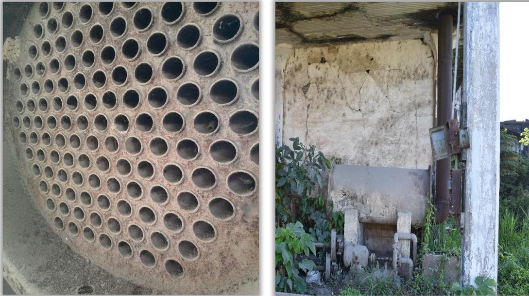
**Figuras 76 y 77.** Izquierda, pirotubos de la caldera. Derecha, vista lateral de la caldera (fotografías: Tobar, 2019).
