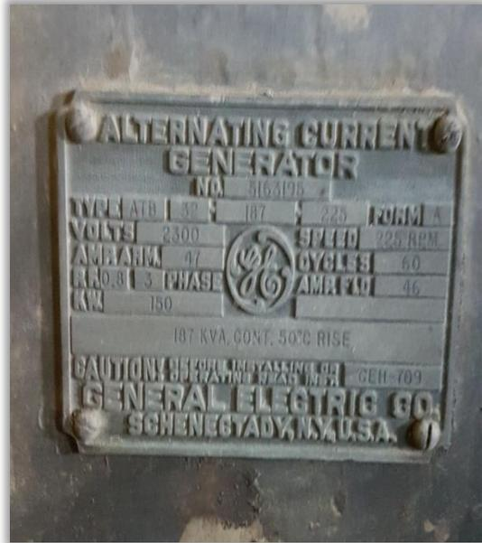
**Figuras 70 y 71.** Izquierda, generador de corriente alterna, remanente 1. Derecha, placa identificatoria del generador, marca *General Electric* (fotografías: Tobar, 2019).
