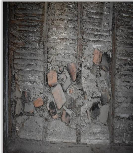
**Figuras 41 y 42.** Izquierda, muro de bahareque encementado. Derecha, detalle de los materiales constructivos del muro (fotografías: Tobar, 2019).
