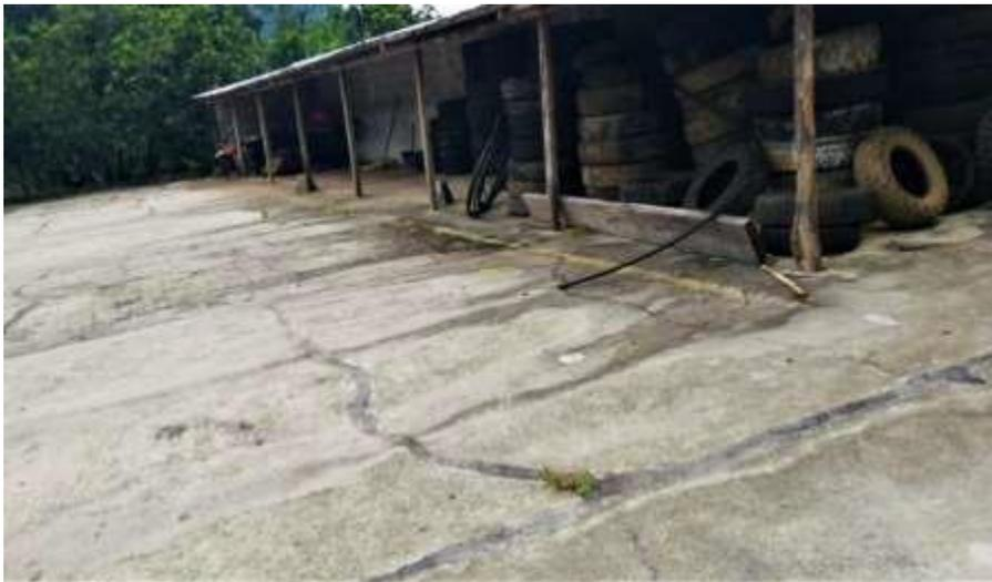
Figura 57. Patio de Secado 2, obsérvese la erosión del concreto, tomada por la autora 2020.
