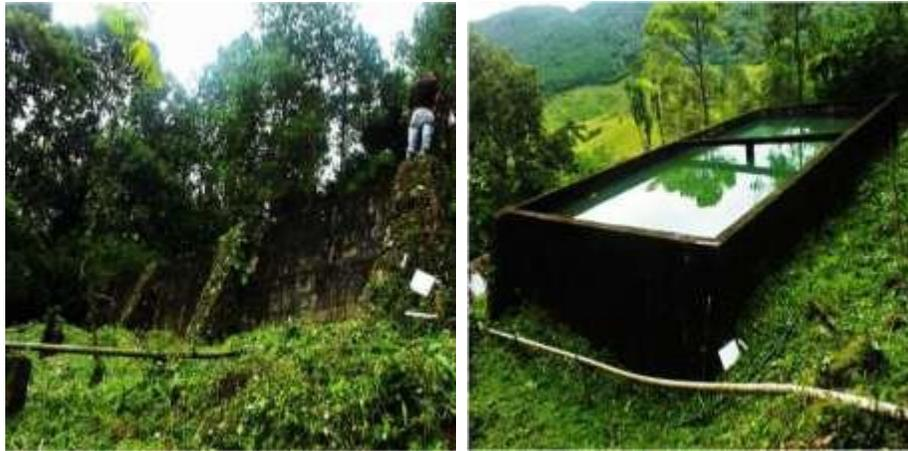
Figura 14. Pileta 2: se observan los tubos de PVC canalizando el agua al reposorio. Generalmente estos están cubiertos con planchas de plásticos la biga ayuda a sostener el mismo.
