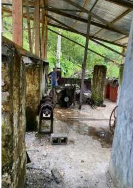
Figura 20. Área de beneficiado antiguo o primigenio, nótese las columnas de calicanto. Fotografía por la autora noviembre 2020, se estaba colocando techo de lámina con parales de pino seco, unos días antes de la tormenta Eta e Iota 2020.
