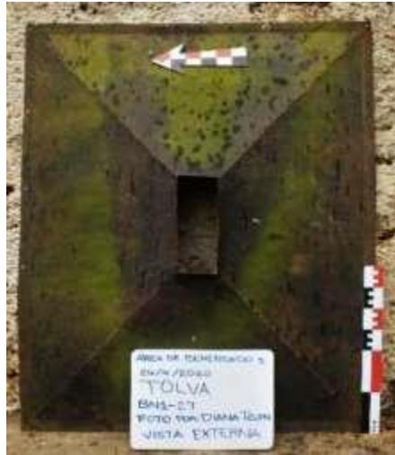
Figura 42. TOLVA semiplana, se observa la oxidación y erosión del metal. El moho por estar a intemperie. Ubicada en Beneficio antiguo. Vista exterior. Fotografía de campo 2020
