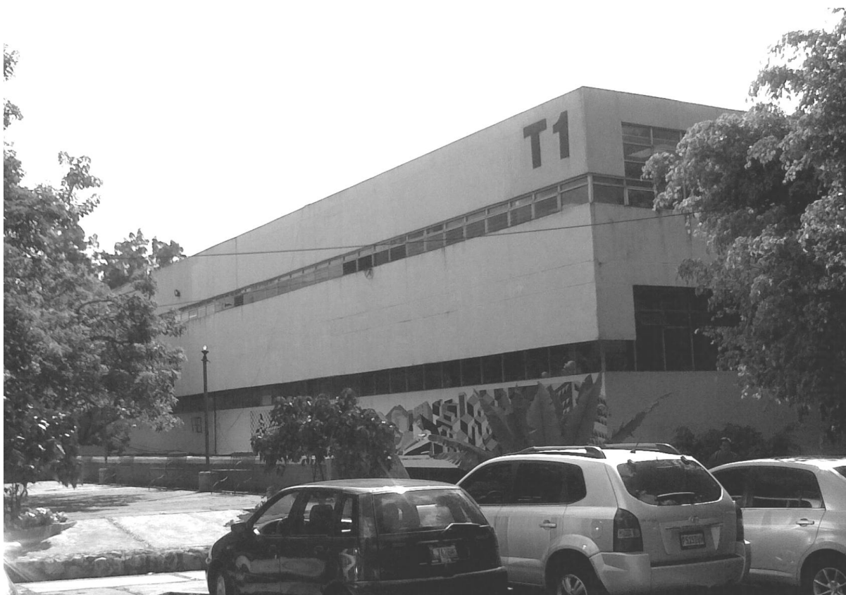
Foto del edificio T-1. Fuente:
