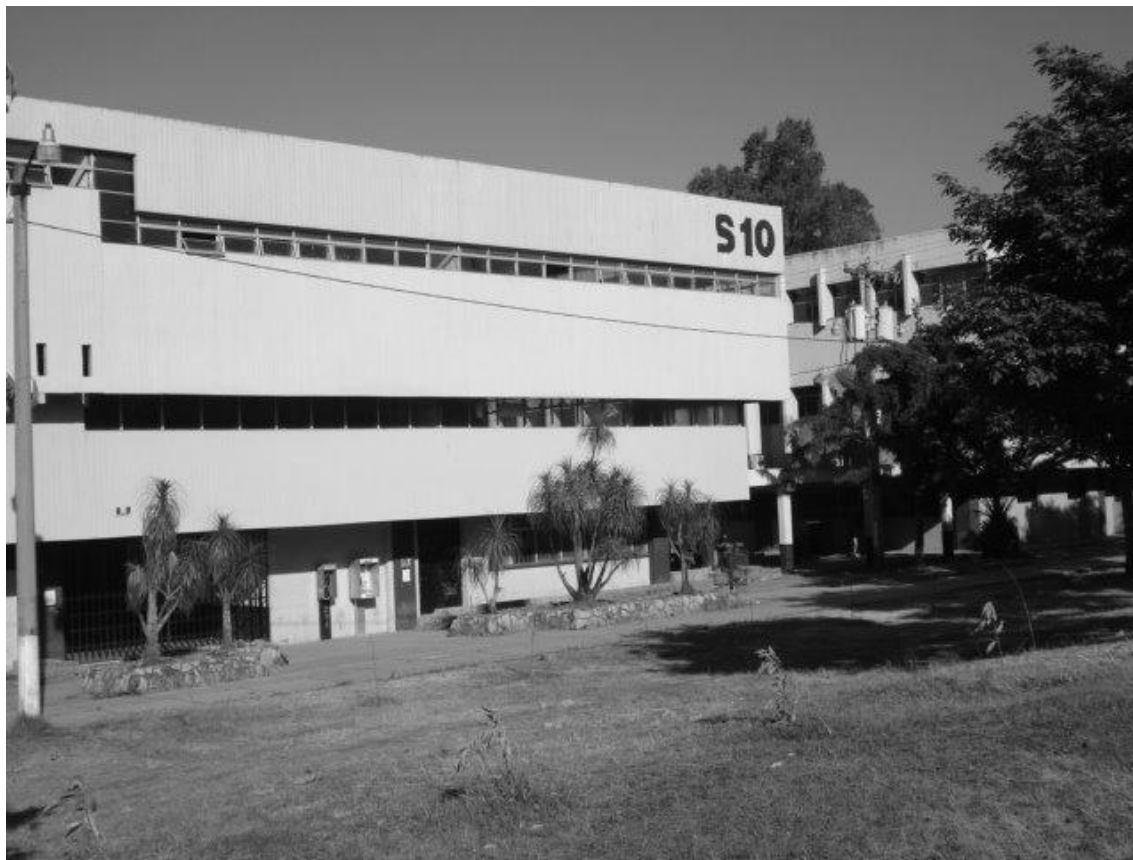
Foto del edificio S-10. Fuente: Disponible en línea el 16 de octubre de 2017, en: http://static.panoramio.com/photos/large/16353903.jpg
