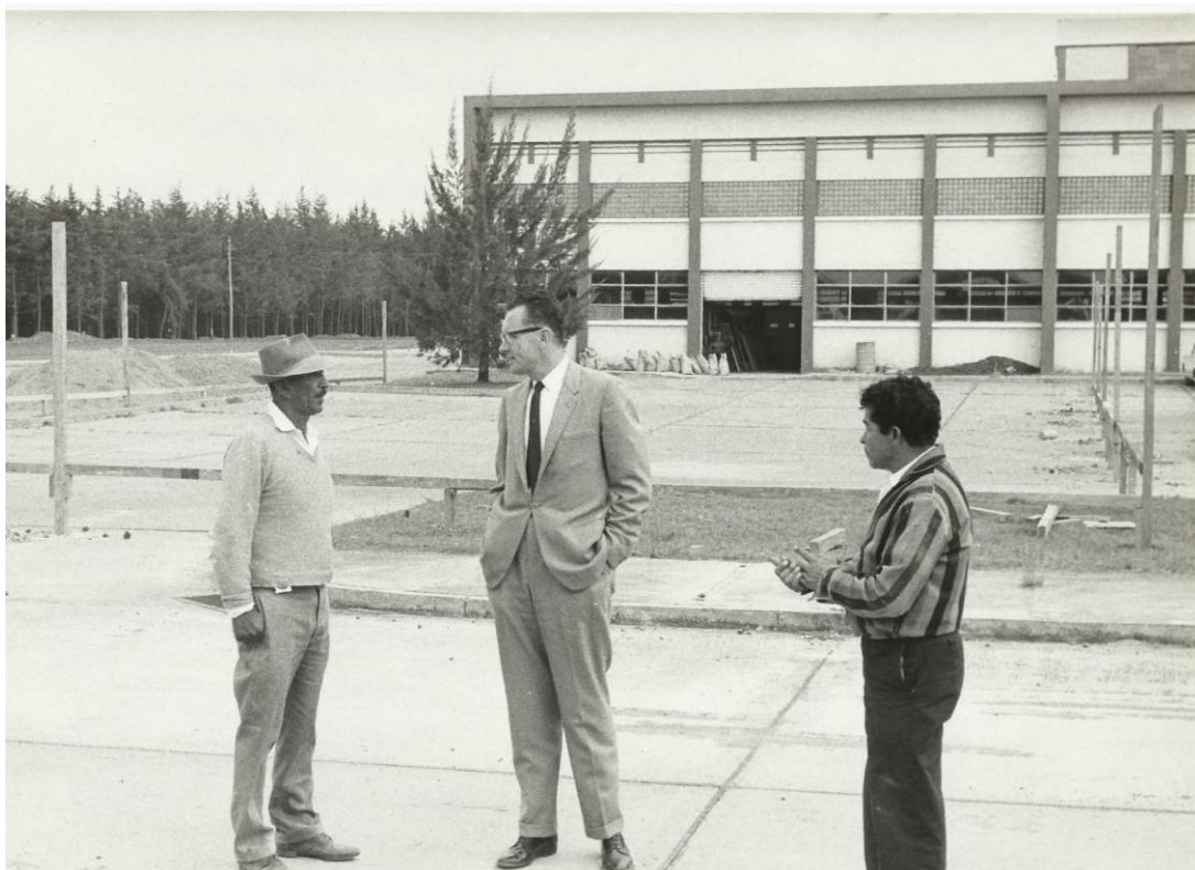
Foto del edificio T-5. Fuente: Agusac, Colección de fotografías de la División de Publicidad de la Universidad de San Carlos de Guatemala, enero, 1966
