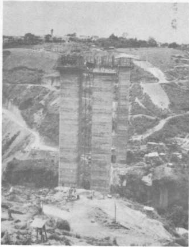
VISTA PANORAMICA PUENTE EL INCIENSO
