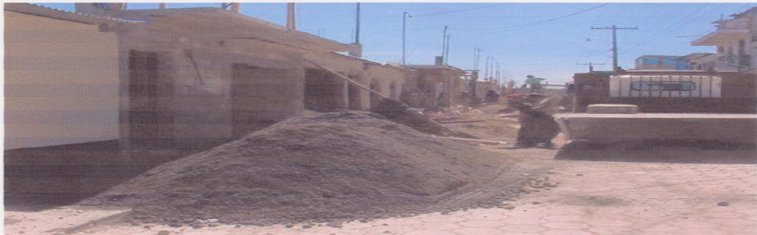
VIVIENDAS EN EJECUCION
