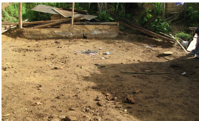
Viviendas dañadas sin ningún apoyo para su restauración
