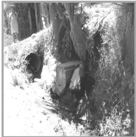
Condición de drenajes
