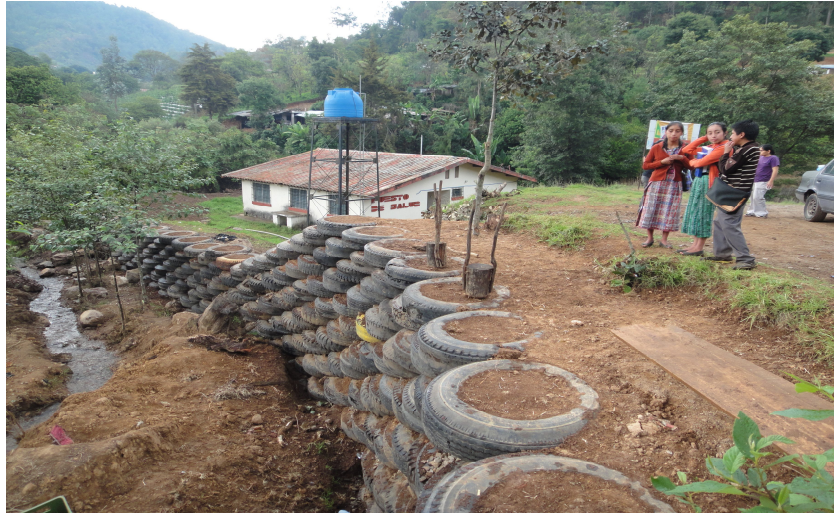
Fuente: Meeylyn Mejía Elaboración de muro perimetral por la comunidad de Patzaj, con el apoyo de las autoridades locales y estudiante de EPS.
