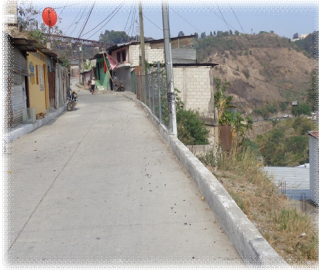
Imagen 20 Viviendas ubicadas en la Comunidad El Carmen, áreas de riesgo
