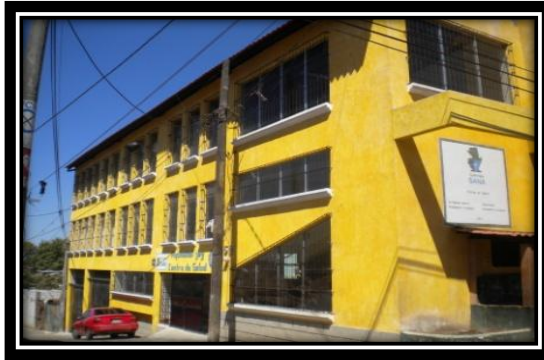
Edificio de Clínicas: Guatemala Sana, Santa María de Jesús. Fuente: EPS 2013
