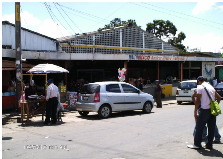
Foto 4. Entrada principal del mercado de mixco
