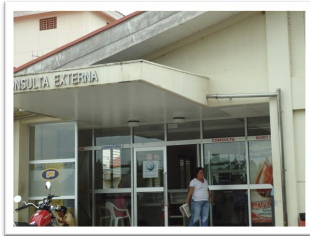
FIGURA 16 Evidencia de señalética
