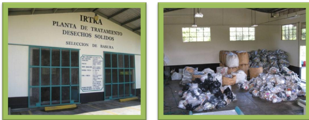
Figura 27 Planta de Tratamiento
