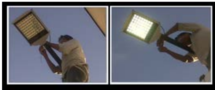
Figura 31 Instalación de Iluminación Led de exteriores
