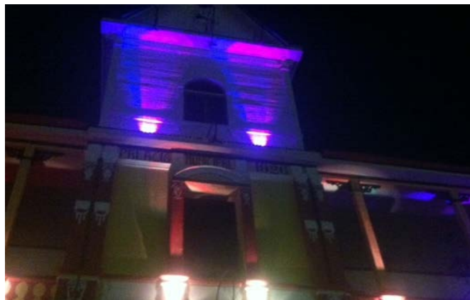
Figura 39 Instalación de iluminación de exteriores
