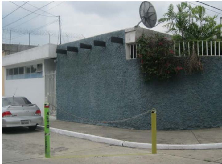
Figura 3 Oficinas de Corporación Canal del Sol
