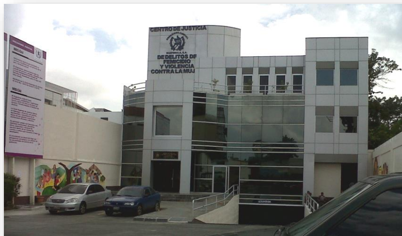
GRÁFICA 32. Instalaciones actuales, zona 10
