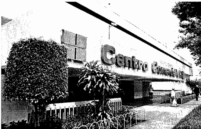
Fachada ingreso peatonal, sobre Boulevard Vista Hermosa.
