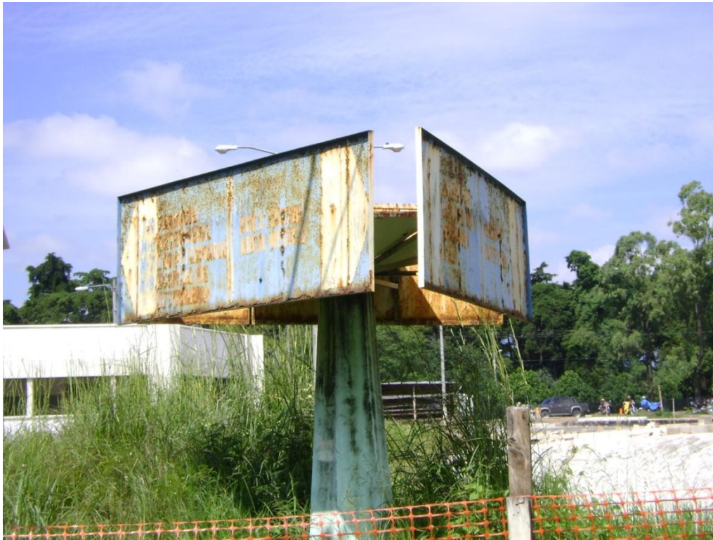
Estado actual de rótulos de información sobre la ubicación de edificios.
