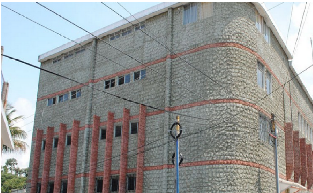
Instalaciones Colegio Mixto Mayaland.
