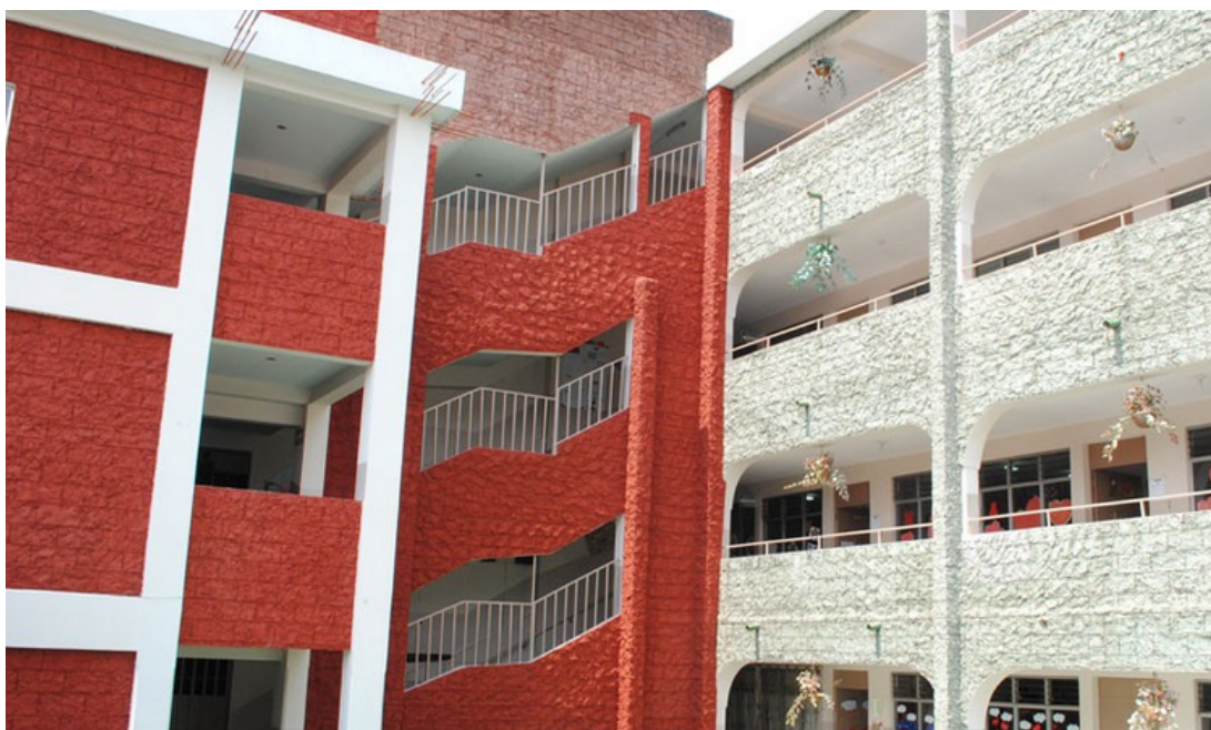
Instalaciones Colegio Mixto Mayaland.
