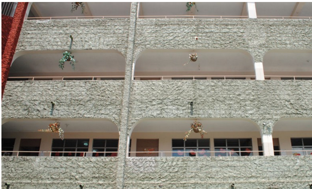
Instalaciones Colegio Mixto Mayaland
