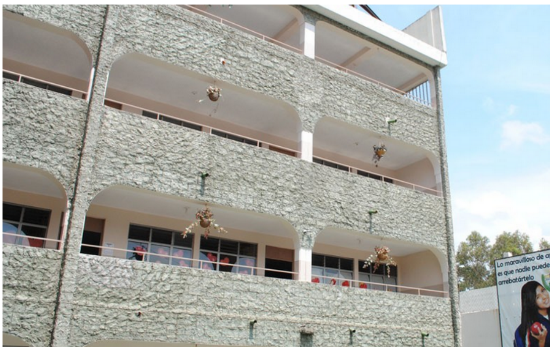
Instalaciones Colegio Mixto Mayaland
