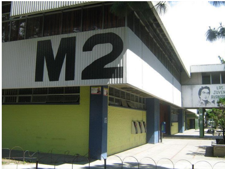
Edificio central de la Escuela de Ciencias de la Comunicación USAC.
