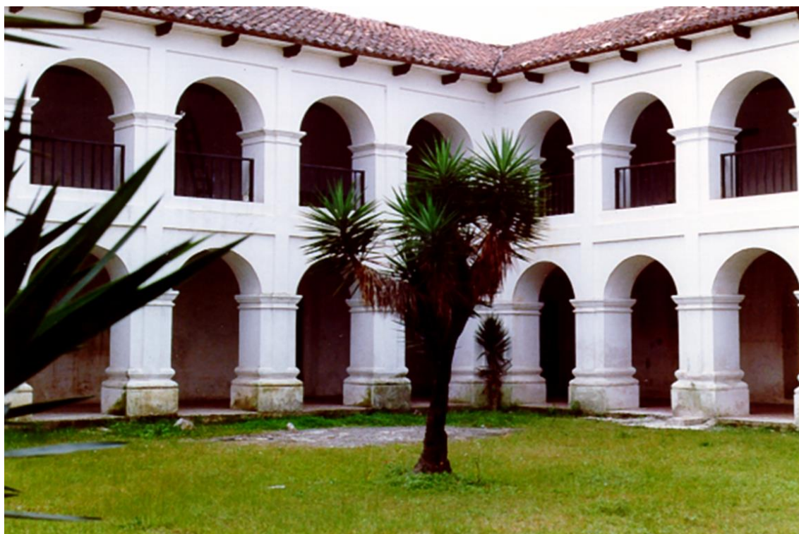
Convento Santo Domingo. Instalaciones RSET. Archivo: Tezulutlán.
