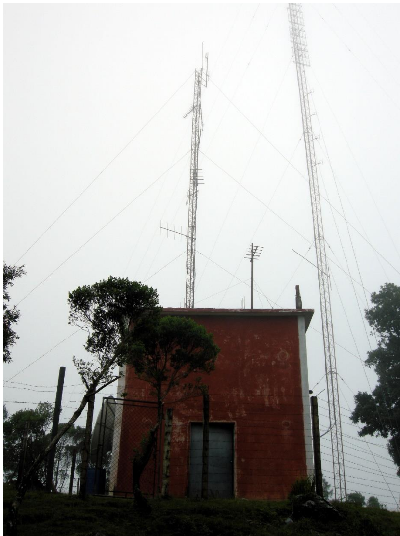
Cerro Pamac, planta de transmisión 2008. Fuente: Archivo RSET
