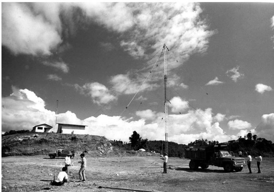
Chichaic, instalación de torre. Archivo Tezulutlán.
