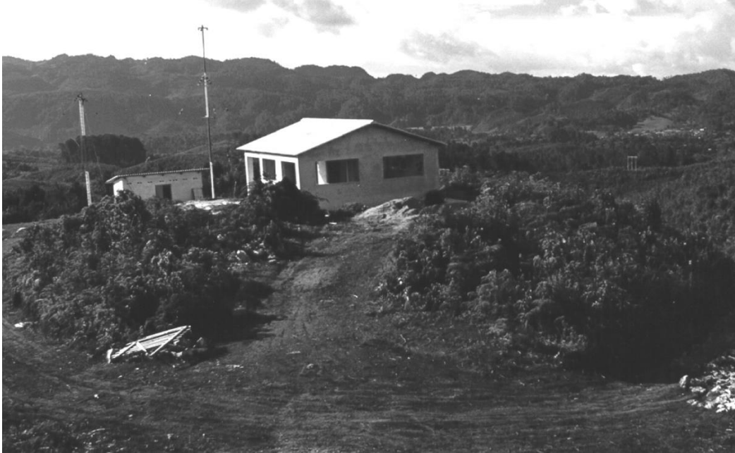
Construcción de la Planta de Transmisión Chichaic. Fuente: Archivo RSET.
