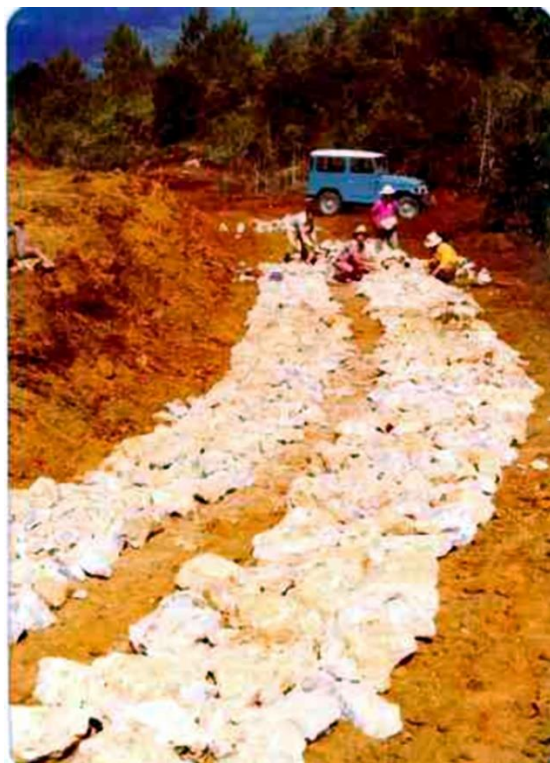
Cerro Chichaic, construcción camino acceso a planta. Archivo Tezulutlán.
