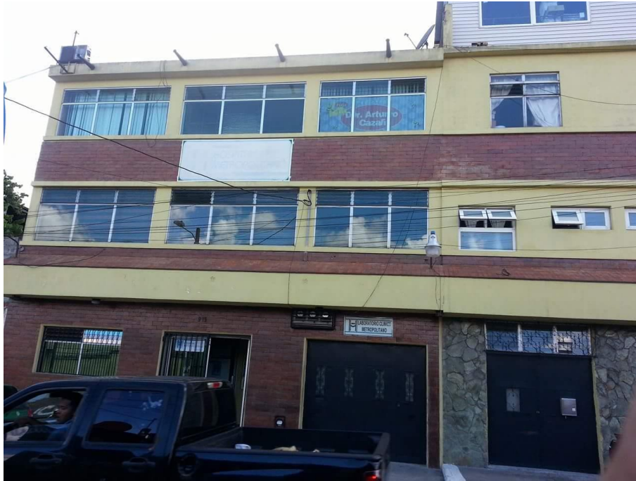
Imagen de la parte externa del hospital sin identificación
