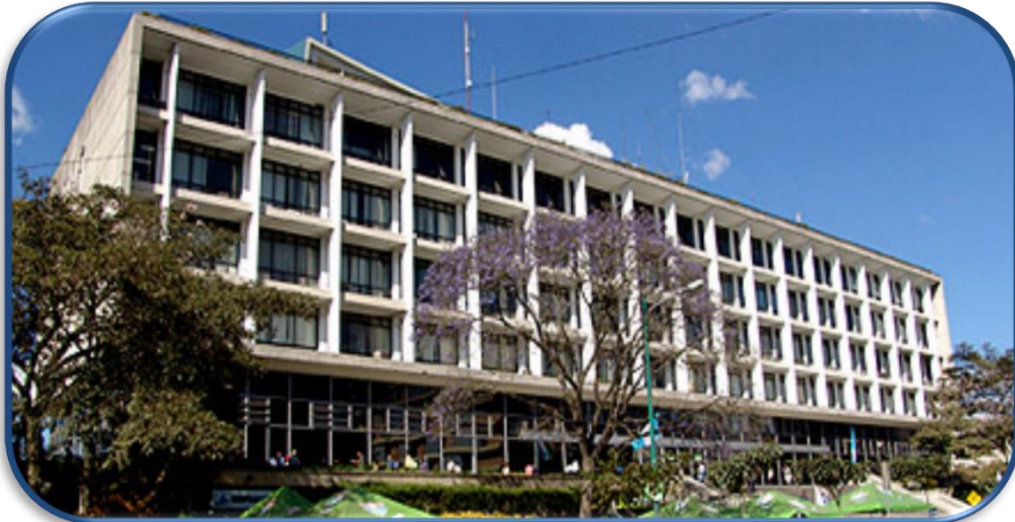
Edificio de la Municipalidad de la ciudad de Guatemala.
