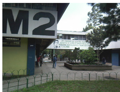
Fachada de Edificio M2
