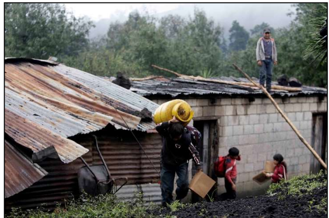
Fotografía 7. Luego de la erupción, pobladores que evacuaron sus viviendas en comunidades aledañas regresaron por sus pertenencias, se observan los daños en los techos. Gobierno de Guatemala 2008-2012
