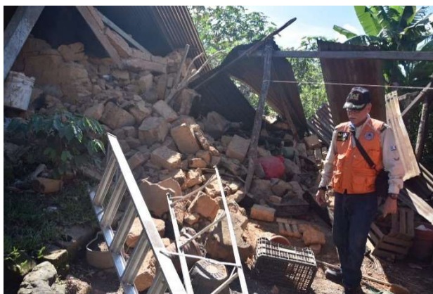
Fotografía 28. Vivienda colapsó por el fuerte sismo del 7 de septiembre de 2017. CONRED.
