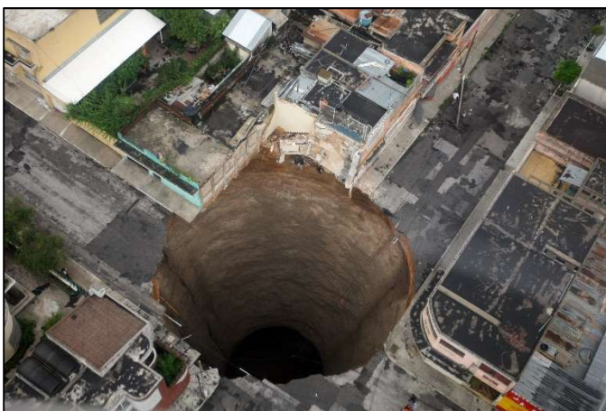
Fotografía 10. Hundimiento en zona 2 de ciudad de Guatemala. Gobierno de Guatemala 2008-2012
