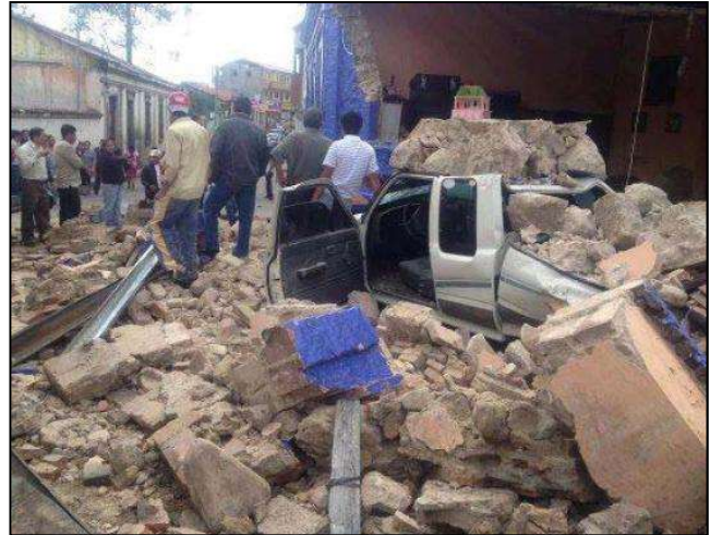
Fotografía 18. Colapso de viviendas en San Marcos debido al terremoto. CONRED.
