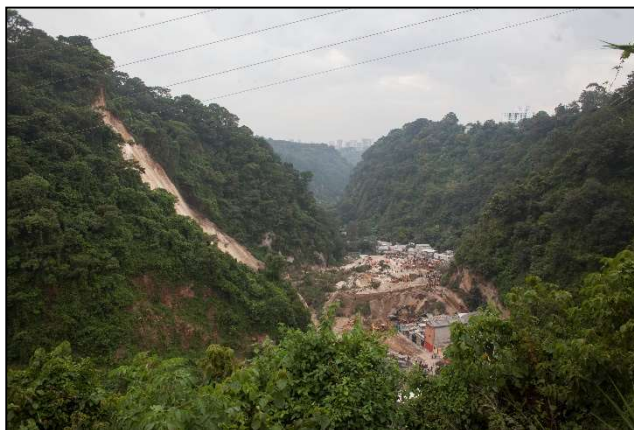
Fotografía 20. Deslizamiento que soterró a las familias en El Cambray II. CONRED.
