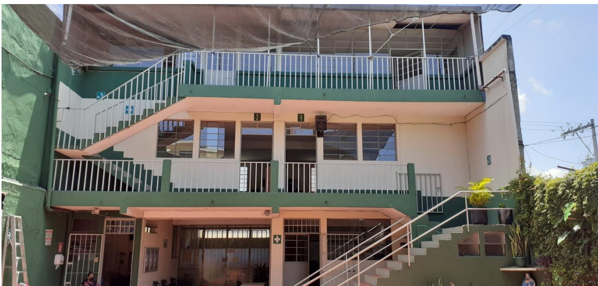
Vista de del interior del Colegio
