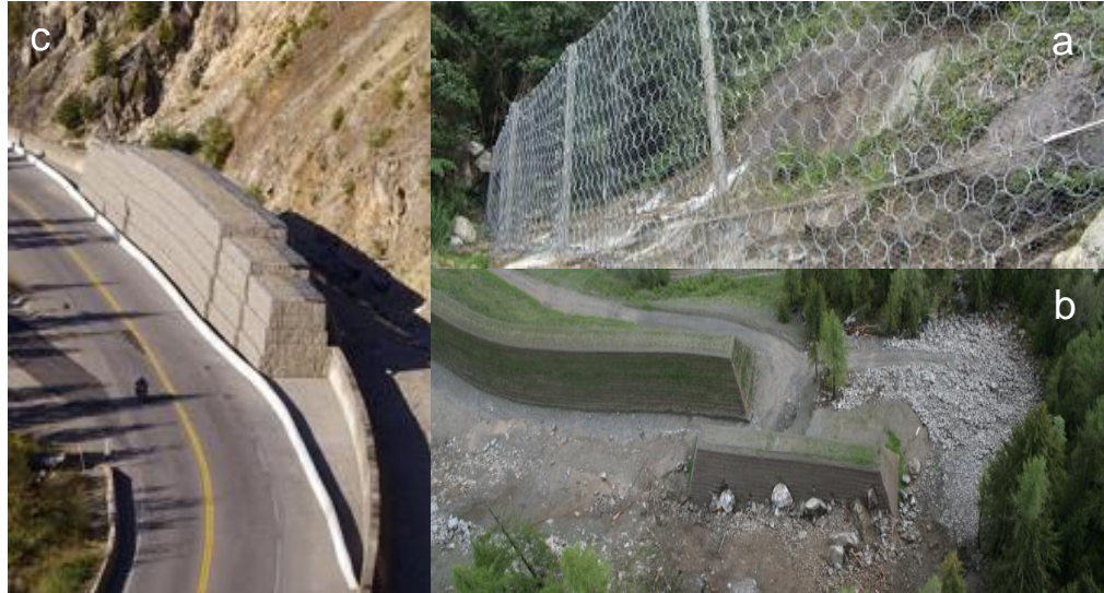
a) malla metálica b) diques c) gaviones.
