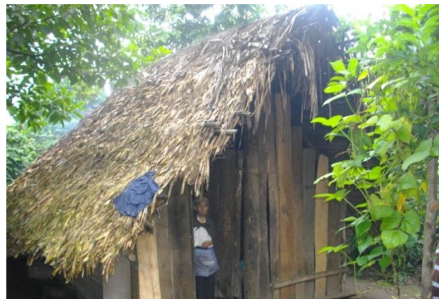
Fotografía no. 1 Como esta construido la casa
