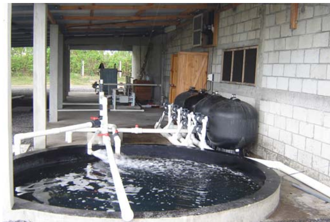
Figura No. 6 Pozo de agua salada y respectivos filtros de carbón
