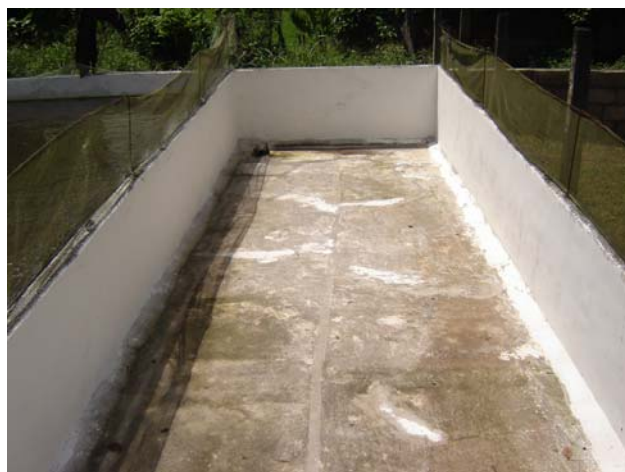
Figura No. 7 Tanque sometido a proceso de limpieza y desinfección
