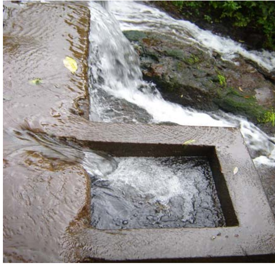
Anexo No. 5 Toma de agua de la Fuente #1
