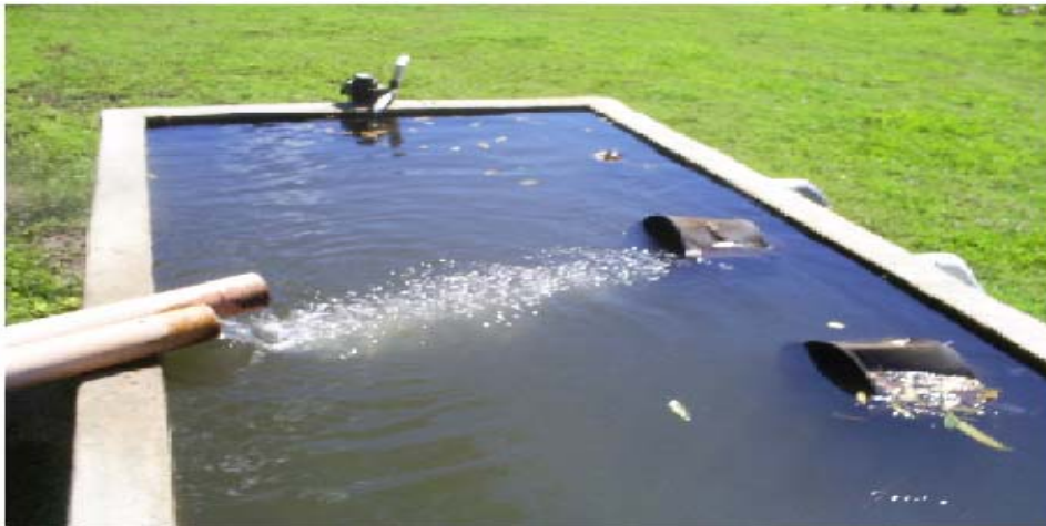
Anexo 2. Filtros en forma de canasta que evitan la entrada de basura a los estanques.
