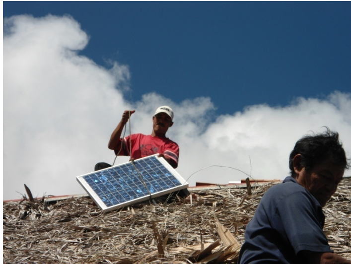
Anexo No 4. Colocación de paneles solares, donados por FUNDAECO, en el centro de acopio (Trabajo de campo, 2011).
