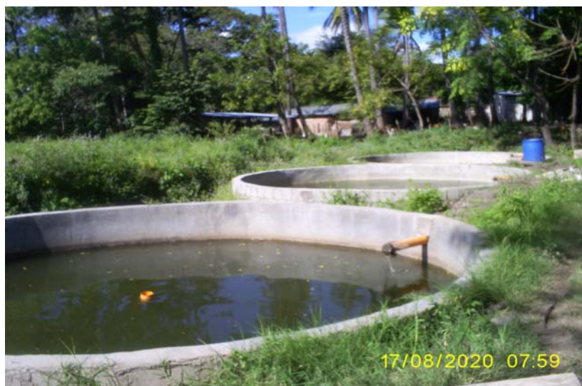
Anexo 8 Estanques de reproductores
