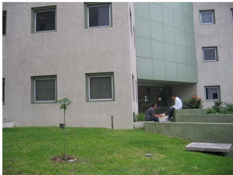
Anexo 8: Edificio de el Instituto de biotecnología
