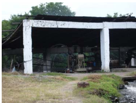
Figura No. 6 Estación de bombeo
