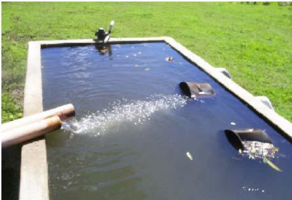
Anexo 2. Caja de Captación
