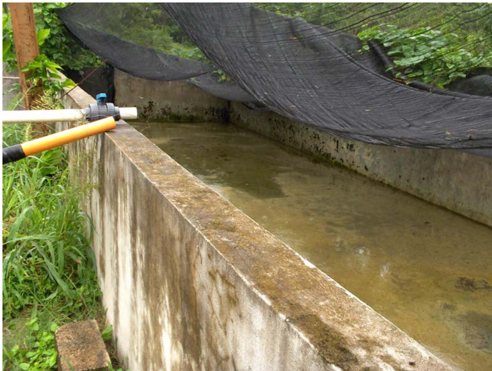
Anexo No. 18 Reservorio de agua para el abastecimiento del sistema de producción de alevines
