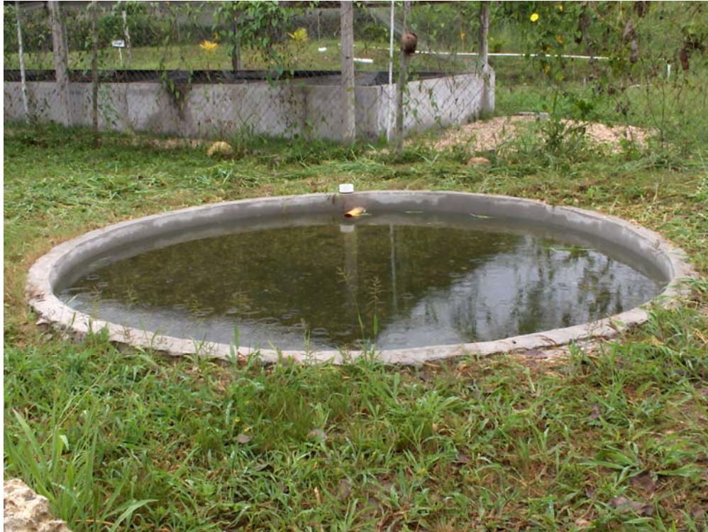
Anexo No. 17 Filtro de agua para reutilización de la misma para las piletas de levante de alevines
