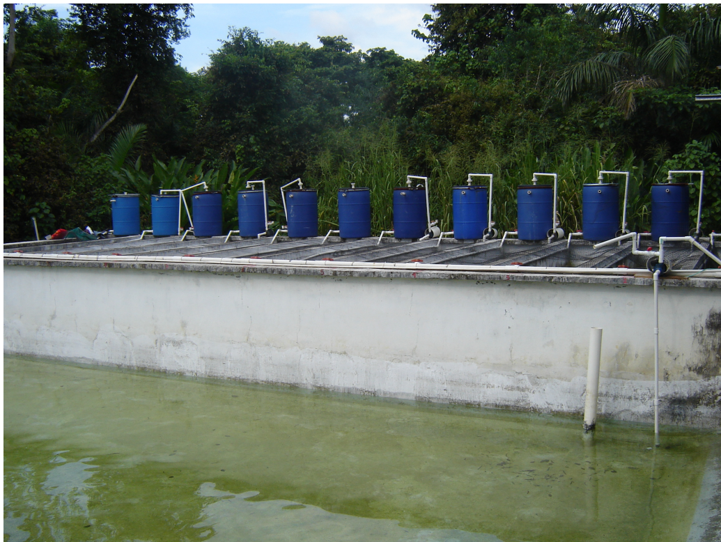
Figura No. 5 Filtros de carbono
