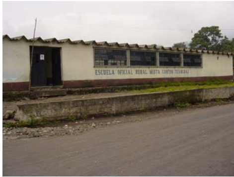
Instalaciones de la Escuela
