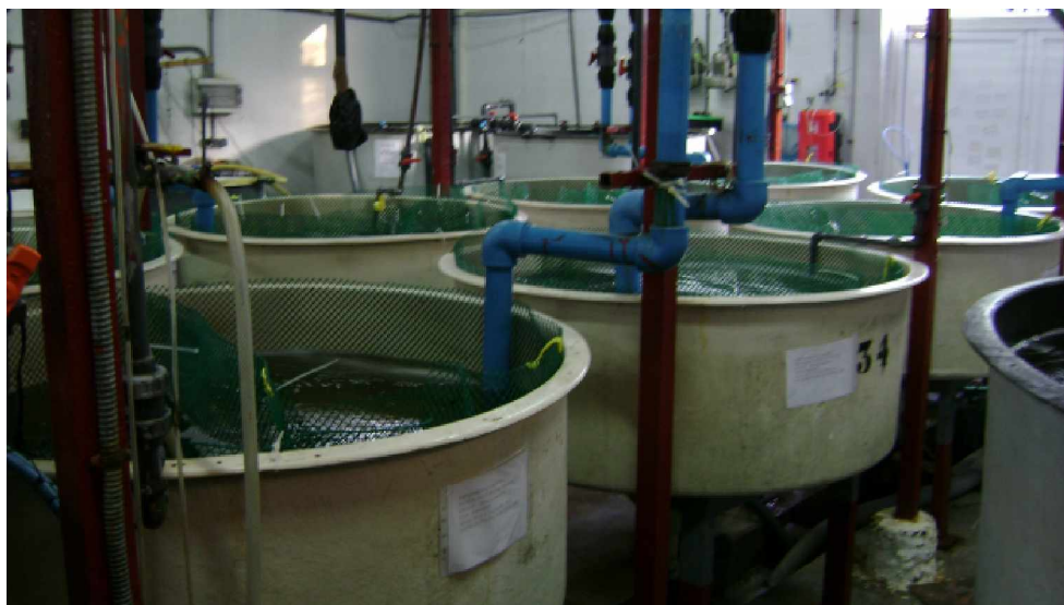
Figura No 7 Tanques de la Línea 3
