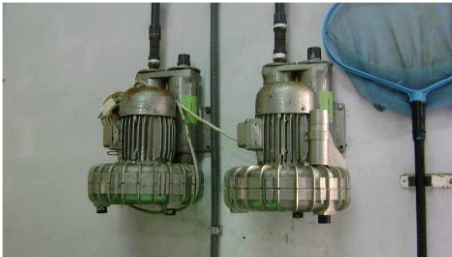
Foto No 10 Electrosoplantes para aireación del sistema
