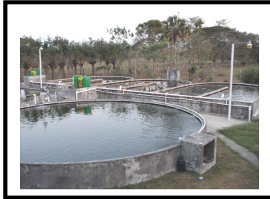
Figura No. 11 Pilas circulares y en forma de D (Trabajo de campo, 2008).
