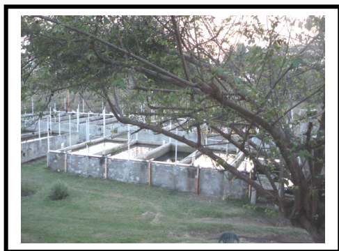
Figura No. 9 Batería de pilas para reproducción (Trabajo de campo, 2008)
