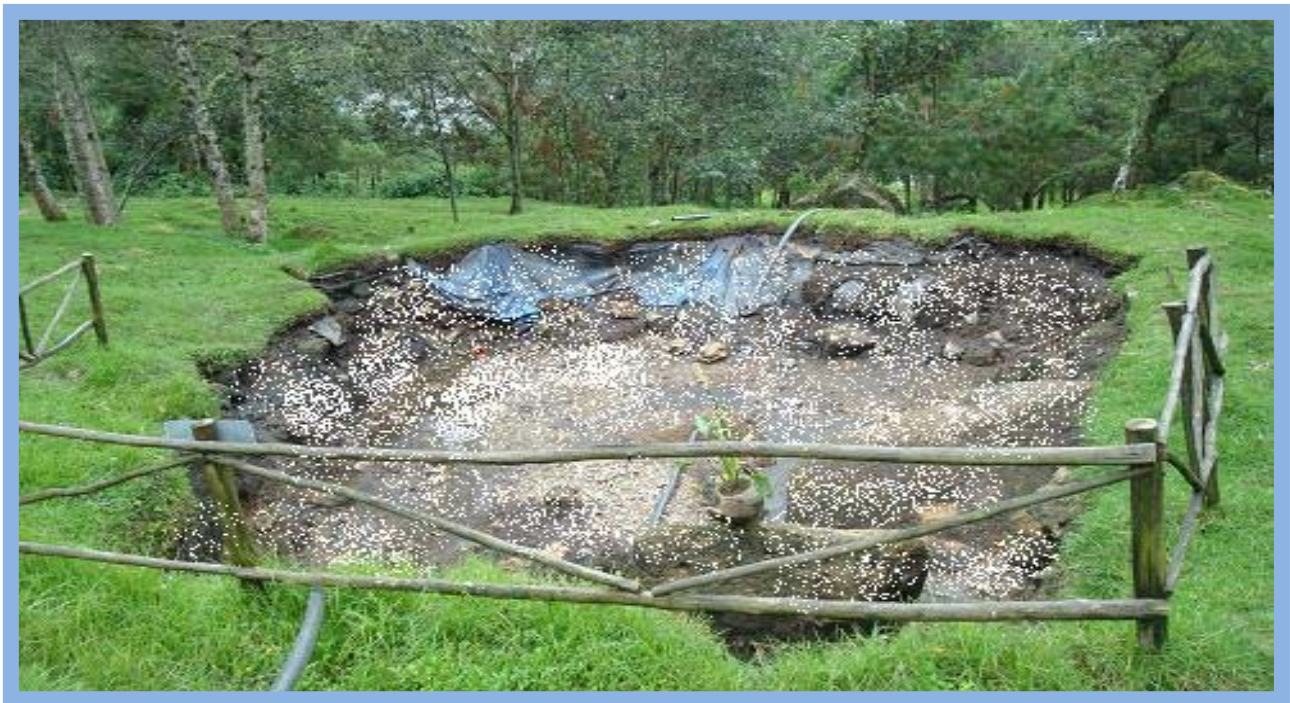
Anexo No. 3. Estanque No. 8 Vaciado y encalado
