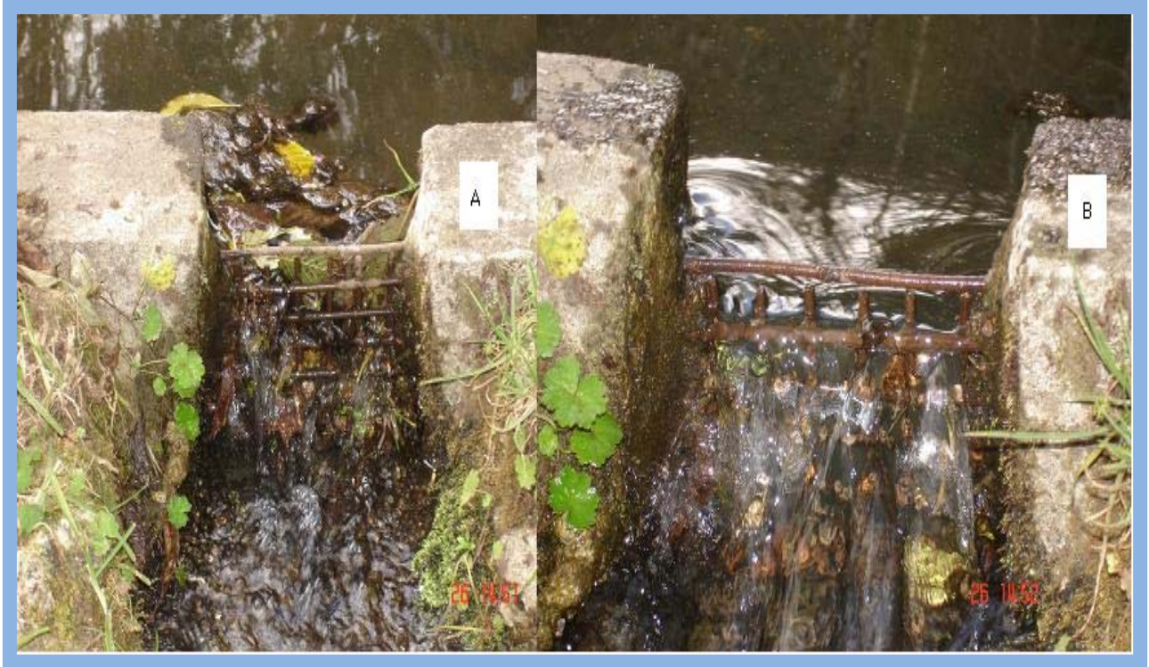
Anexo No. 2. A) Filtro obstruido por hojas y palos, B) Filtro limpio de hojas y palos
