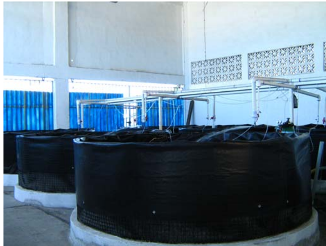
Figura No. 7: Sistema de tanques de reproductores de Pámpano
