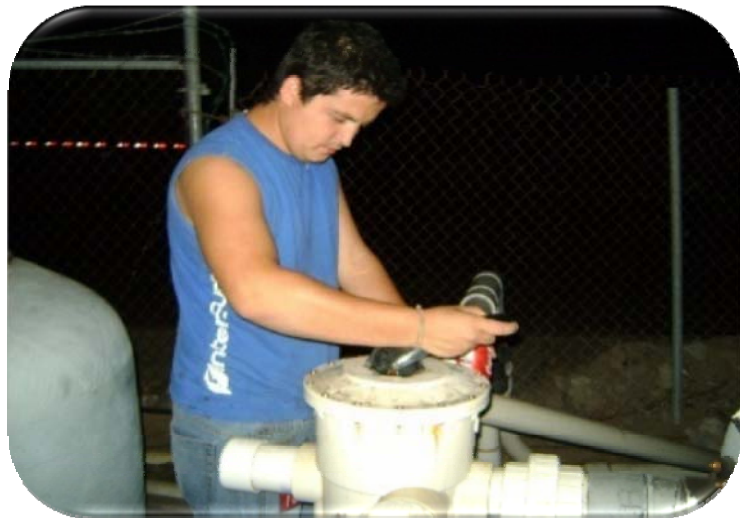
Figura No. 4. Retro-lavado de filtro desarenador.
