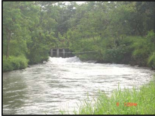
Figura No. 3. Canal de abastecimiento
