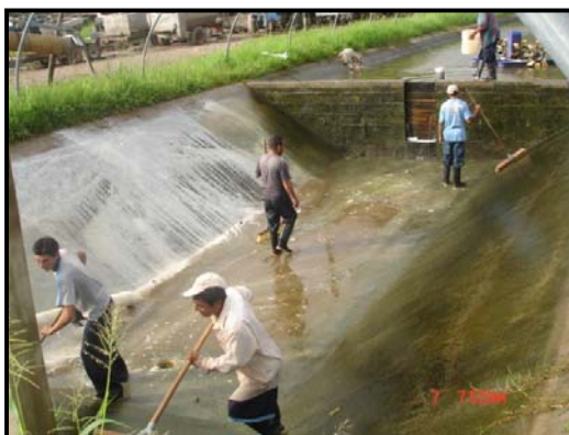
Figura No. 16. Limpieza de estanque
