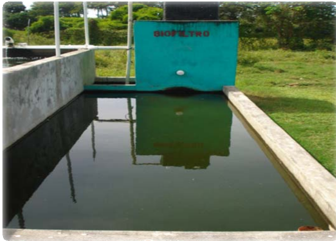
Anexo No. 1 Sedimentador y biofiltro.
