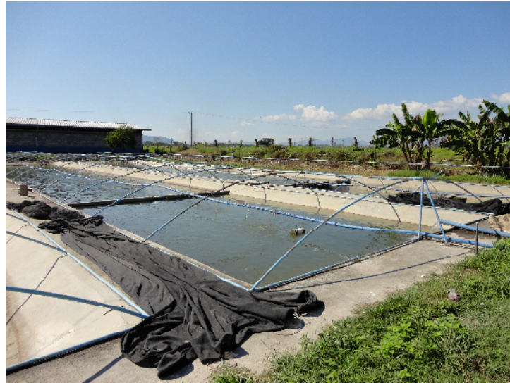
Figura No. 6. Estanque trapezoidal de concreto (Trabajo de campo, 2011)
