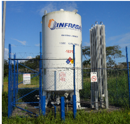
Figura No. 13. Termo con 1500 galones de oxigeno liquido en el área de Grow-out (Trabajo de campo, 2011)
