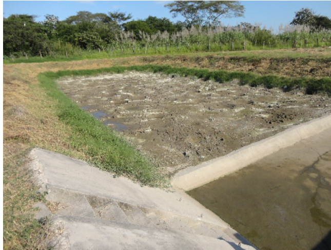
Figura No. 4. Estanque rectangular de tierra, con gradas de acceso (Trabajo de campo, 2011)
