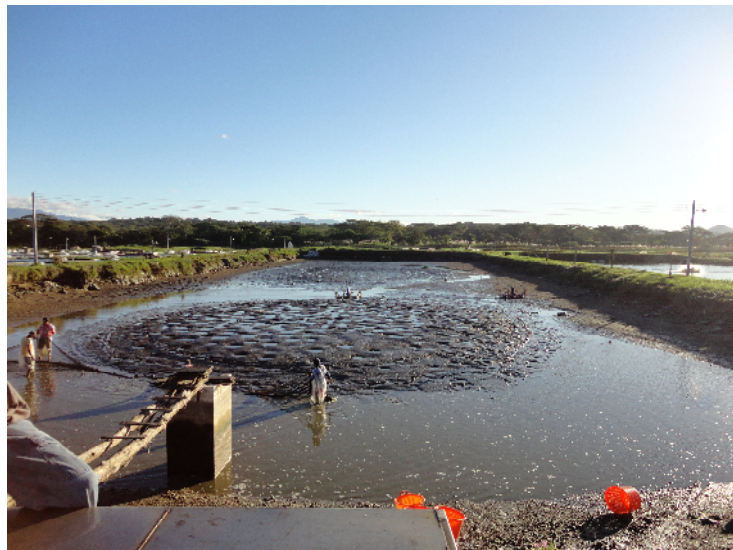
Figura No. 7. Estanque rectangular con monje de concreto (Trabajo de campo, 2011)
