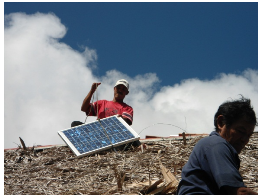
Figura 35. Instalación de Paneles Solares. Fuente Archivo.
