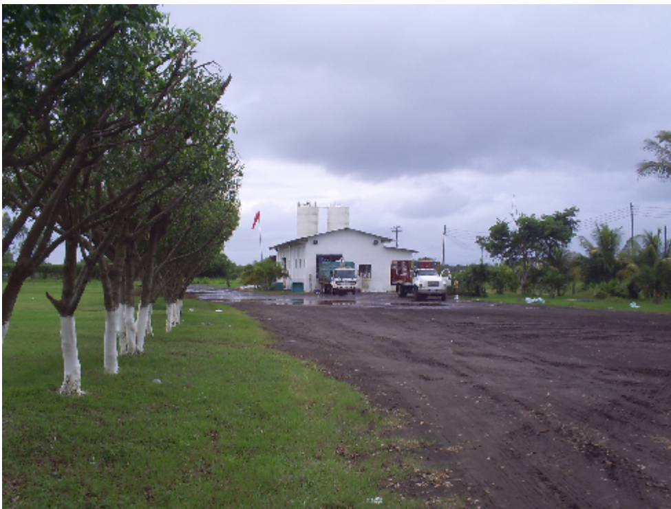
Anexo No. 4: Planta procesadora de camarón, finca Tecojate. Fuente: Trabajo de campo (2011).
