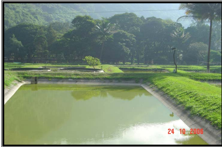
Figura No. 1 Extensión de la estación piscícola
